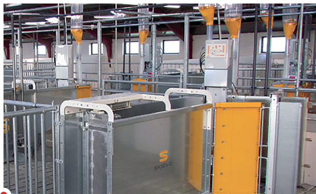
Fot. 1. Elektroniczna stacja paszowa dla loch (źródło: materiały informacyjne firmy Skold)
